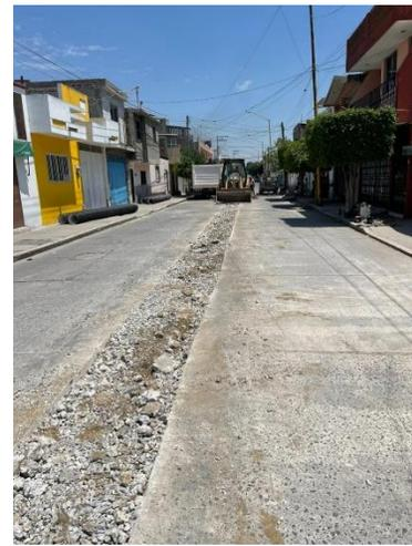
Con una inversión de \$ 814,479.31 pesos (ochocientos catorce mil cuatrocientos setenta y nueve pesos 31/100) se llevó a cabo la rehabilitación de varias líneas del drenaje sanitario, las cuales se encontraban en condiciones de colapso, esto debido a la antigüedad y el desgaste. Dicha acción generará un mejor servicio a los beneficiarios, pues con ello se evitará posibles problemas en el drenaje. Las calles en las que se realizaron dichas acciones dentro de la cabecera municipal son:
